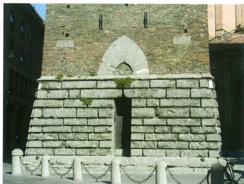
Blocchi di selenite messiniana rivestono il basamento della torre medioevale della Garisenda a Bologna
