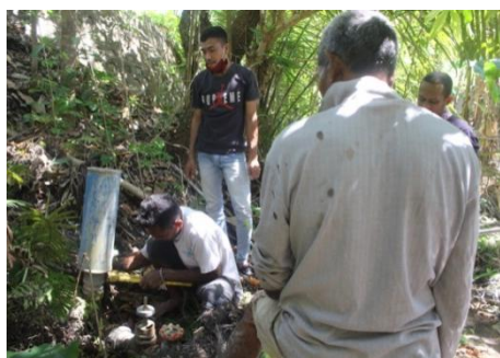
Gambar 3. Pembongkaran Pompa Hydram dari dudukannya
