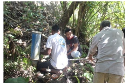
Gambar 5. Pemasangan kembali pompa pada dudukannya
