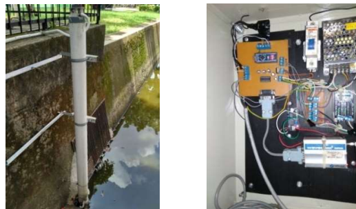
Gambar 3. Pembuatan struktur Sensor dan Panel Kontrol
