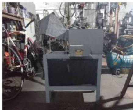
Gambar 6. Mesin Pembangkit listrik tenaga mikrohidro
