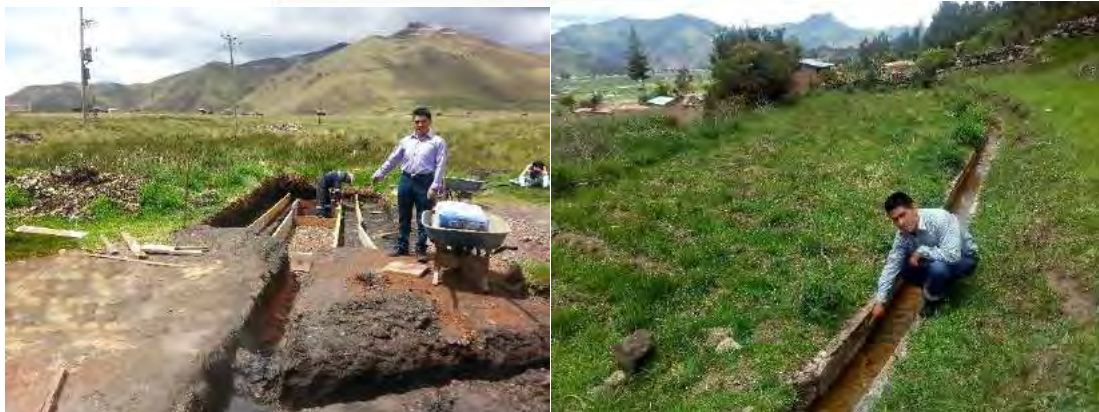
Figura 3. Fotografía izquierda, canal hidráulico en proceso de construcción; fotografía derecha, canal hidráulico existente.
