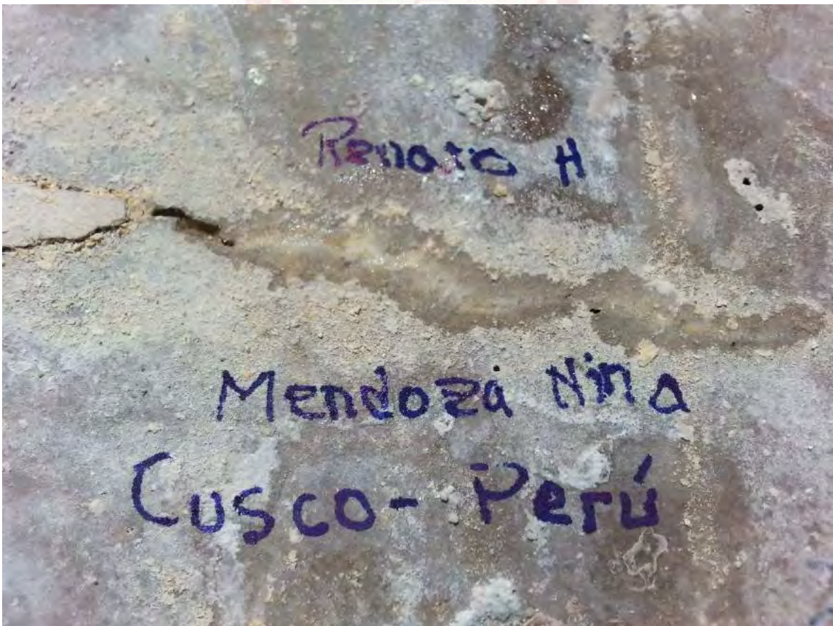
Figura 111. Fisura de concreto reparado mediante la aplicación de bacterias.
