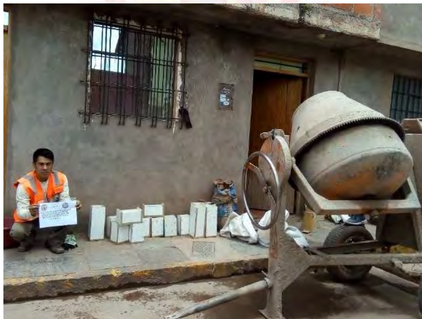
Figura 35. Colocación de moldes en superficie plana.
