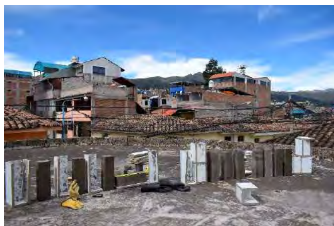
Figura 40. Prismas de concreto desmoldeados.
