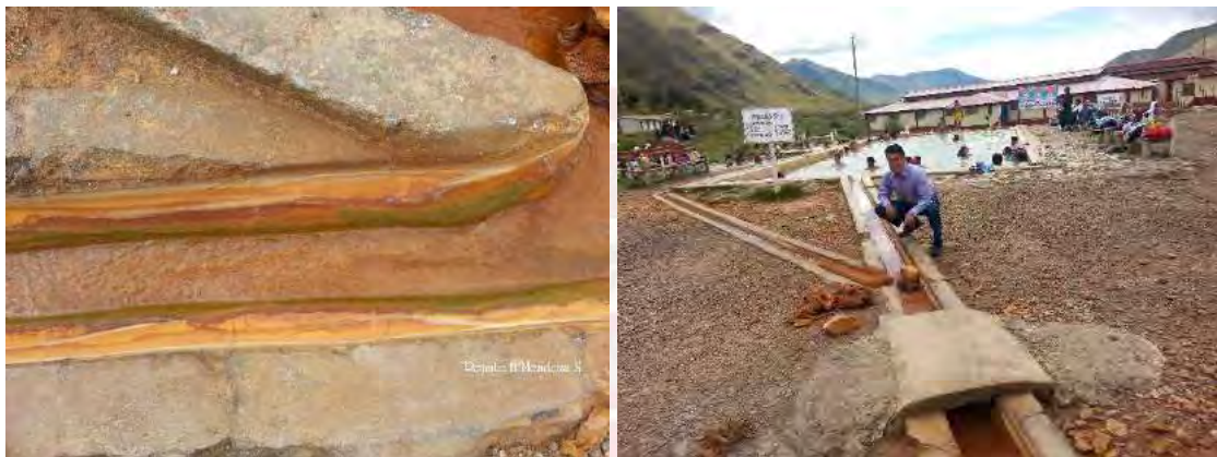
Figura 4. Canal de agua de los baños termales de Occobamba, Sicuani, Canchis - Cusco.
