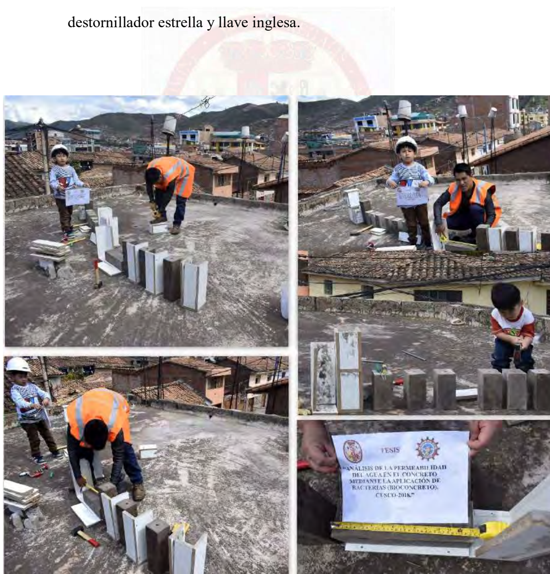
Figura 37. Desmoldeo de prismas de concreto.
