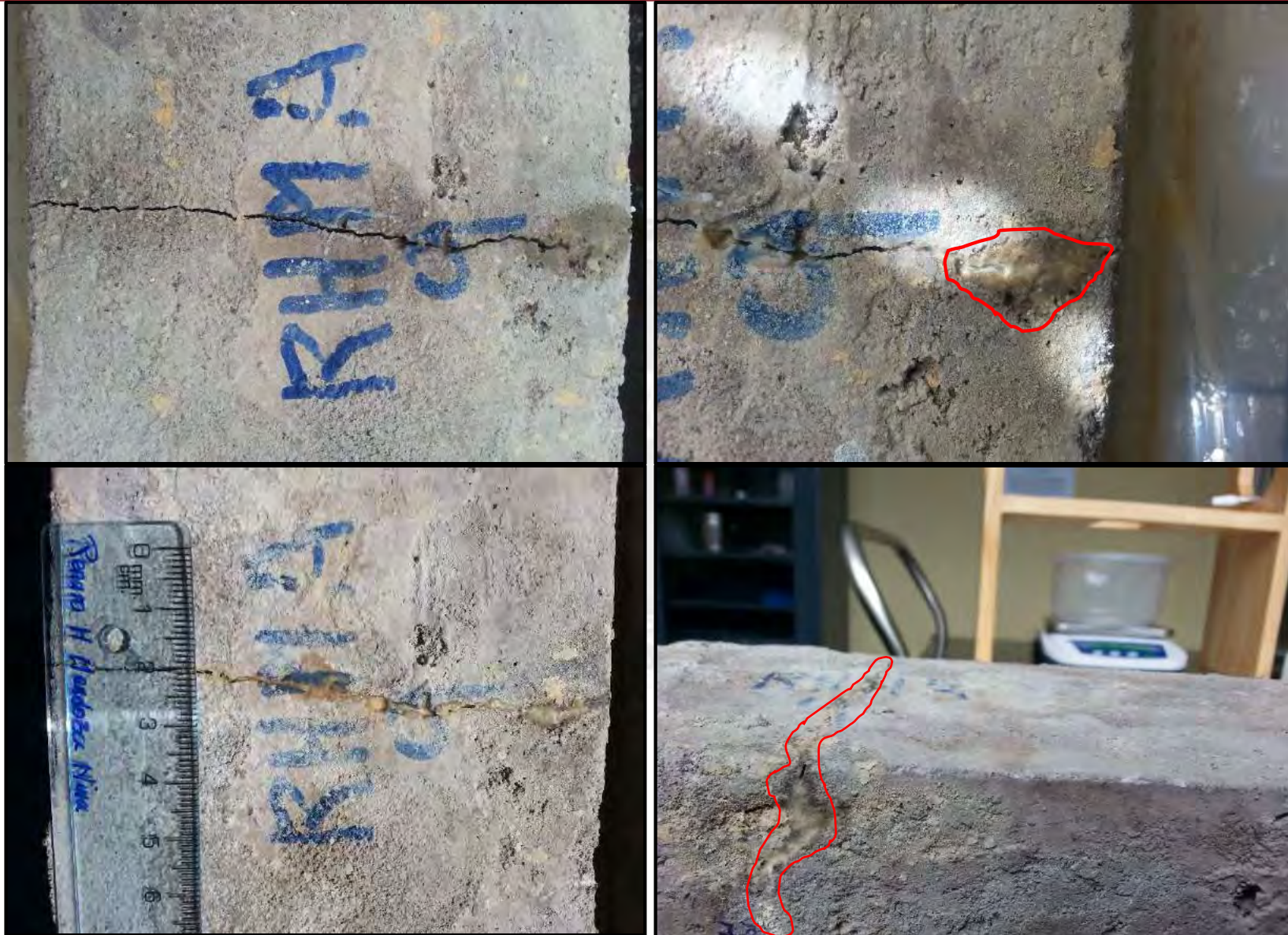
Figura 92. Sellado de fisuras a base de bacterias.
