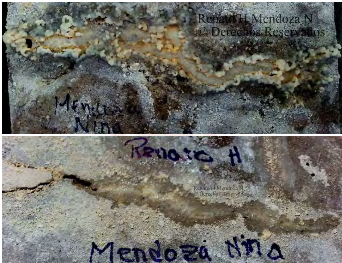
Figura 126. Curación del concreto fisurado a base de bacterias metabolizadoras de lactato de calcio para convertirlos en carbonato de calcio (calcita) y cerrar de esta manera las fisuras producidas en las muestras.
