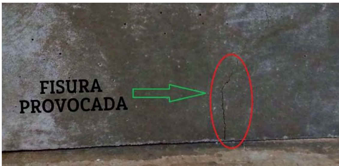
Figura 47. Prisma de concreto fisurado de manera intencional para la reparación a base de bacterias.
