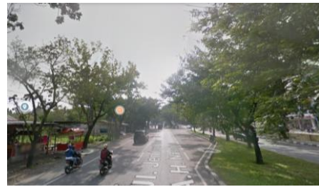
Gambar 4. Kondisi Ruas Jalan AH Nasution
