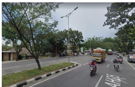
Gambar 3. Kondisi Ruas Jalan AH Nasution.
