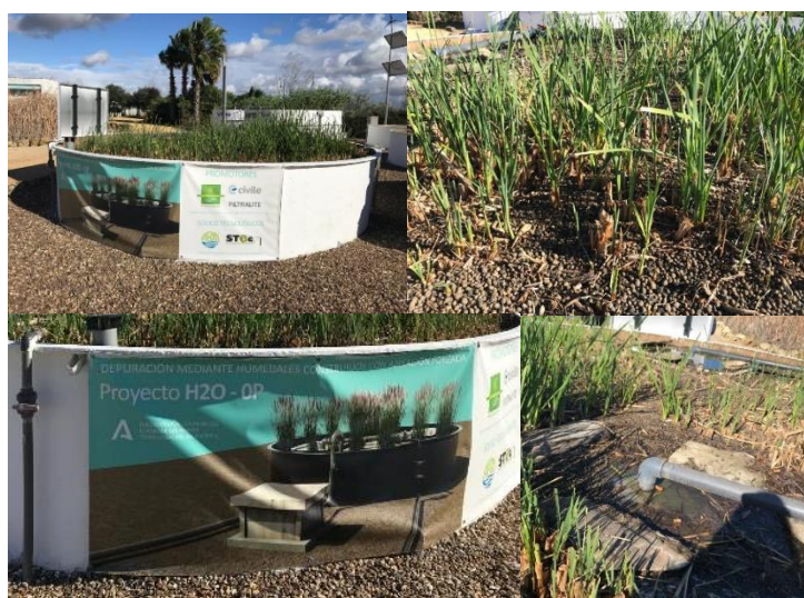
Figura 14. Humedales de Aireación Forzada contruidos en funcionamiento (Fuente: Elaboración propia a partir del Proyecto H2O-OP en La fundación CENTA, Carrión de los Céspedes (Sevilla).
