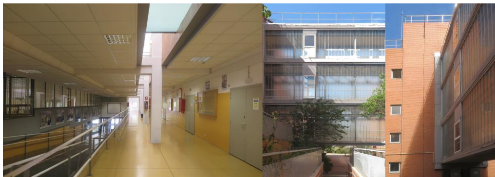
Fig. 5. Facultad de Farmacia, 1985. Estado actual. Fuente: Imagen de elaboración propia.
