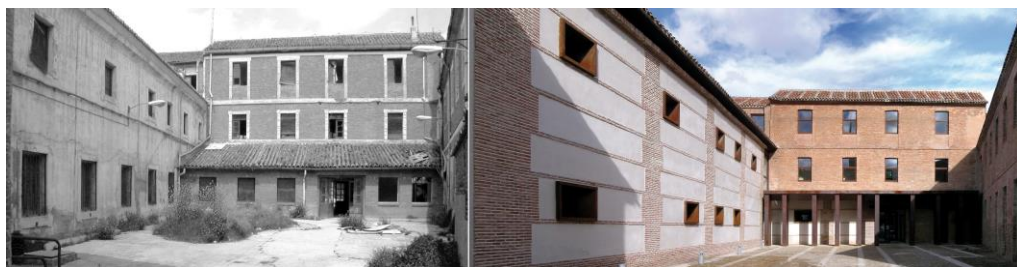
Fig. 9. Colegio de la Trinidad Calzada, 1612. Archivo del Movimiento Obrero. Estado del patio en 2008 y después de la intervención, 2010. Fuente: OGIM-UAH.
