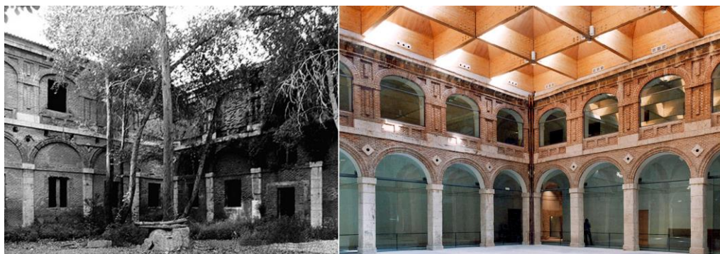
Fig.3. Colegio del Carmen Calzado, 1640. Escuela de Arquitectura. Estado del claustro en 1998 y después de la intervención en 1997. Fuente: OGIM-UAH.
