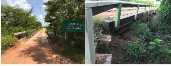
Figura 9.3 Pontes 01 e 19, respectivamente, com proteção de guarda-corpo.
