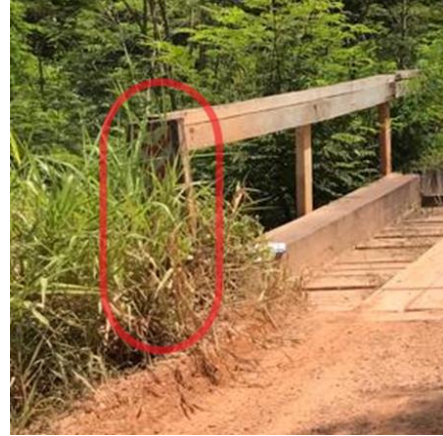
Figura 11.5 Catadióptrico utilizado para sinalização de pontes com capacidade de visualização reduzida, devido à presença de vegetação na entrada da ponte.
