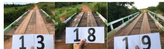
Figura 12.6 Pontes que apresentaram pintura como forma de sinalização.
