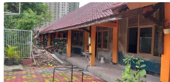
Gambar 11 Renovasi bagian ruang kelas yang mengalami kerusakan
