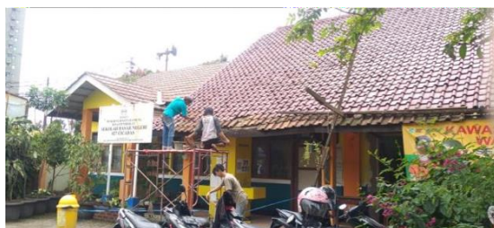
Gambar 10 Renovasi bagian atap yang mengalami kerusakan
