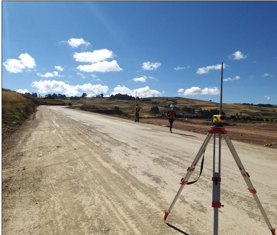
Figura 23: b). Toma de puntos para hallar los desniveles del tramo de la carretera Izcuchaca – Cruzpata con el objetivo de generar pendientes en la vía a evaluar (29 de Mayo del 2021).
