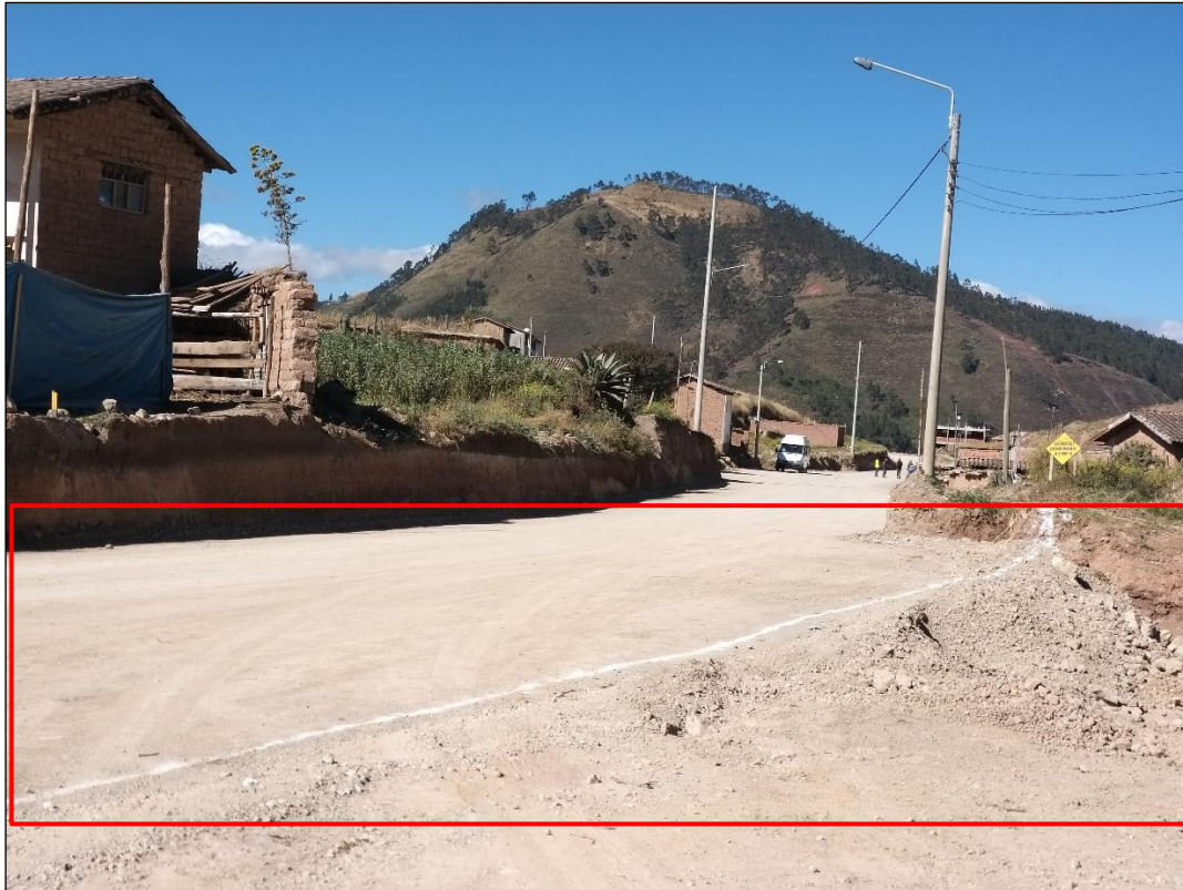
Figura 27: c). Trazo de la calzada (29 de Mayo del 2021).
