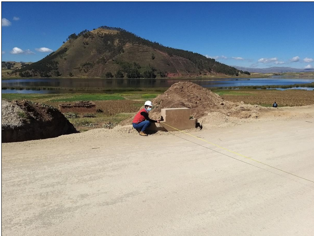
Figura 26: b). Toma de la longitud transversal (ancho de la calzada) del tramo de la carretera (29 de Mayo del 2021).
