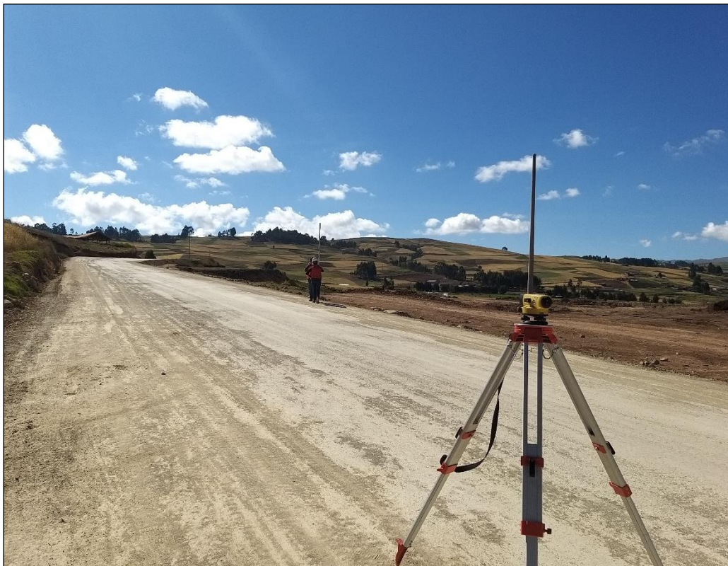
Figura 22: a). Toma de puntos para hallar los desniveles del tramo de la carretera Izcuchaca – Cruzpata (29 de Mayo del 2021).
