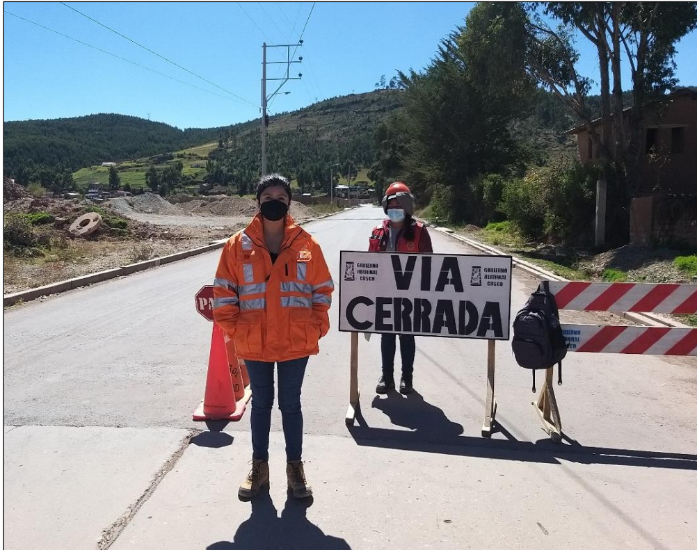
Figura 17: Punto de origen del tramo de la vía Izcuchaca – Cruzpata a evaluar (22 de Mayo del 2021).
