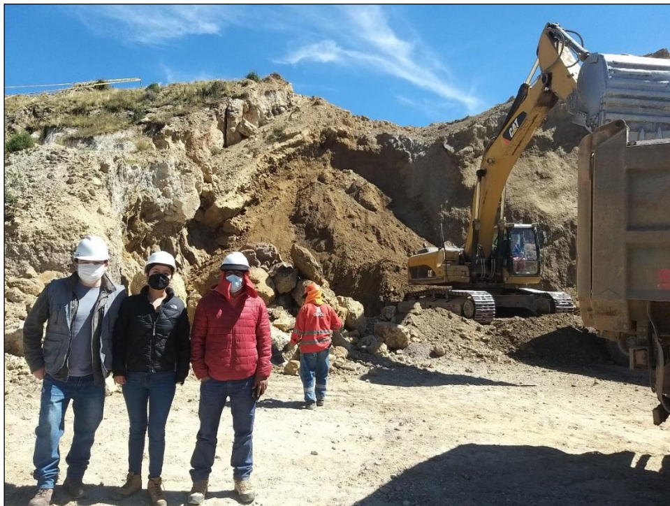
Figura 28: Visita a la Cantera Huchuyqosqo, que provee los agregados que serán empleados en la ejecución de pavimentación de la obra “Mejoramiento de la Carretera Izcuchaca Cruzpata, Provincias de Anta y Urubambacusco” (05 de Junio del 2021).
