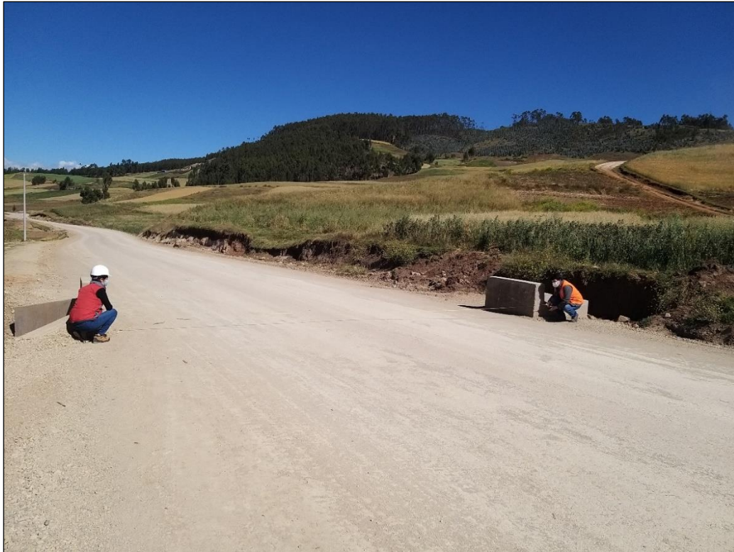
Figura 25: a). Toma de datos para el diseño geométrico del tramo de la carretera (29 de Mayo del 2021).
