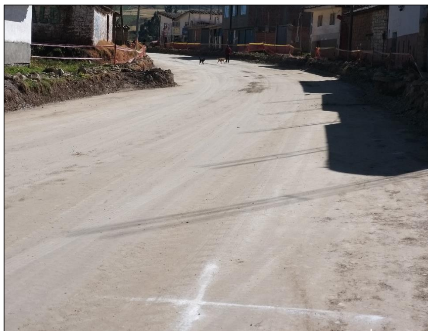
Figura 32: Punto de finalización del tramo de la vía Izcuchaca – Cruzpata a evaluar (05 de Junio del 2021).
