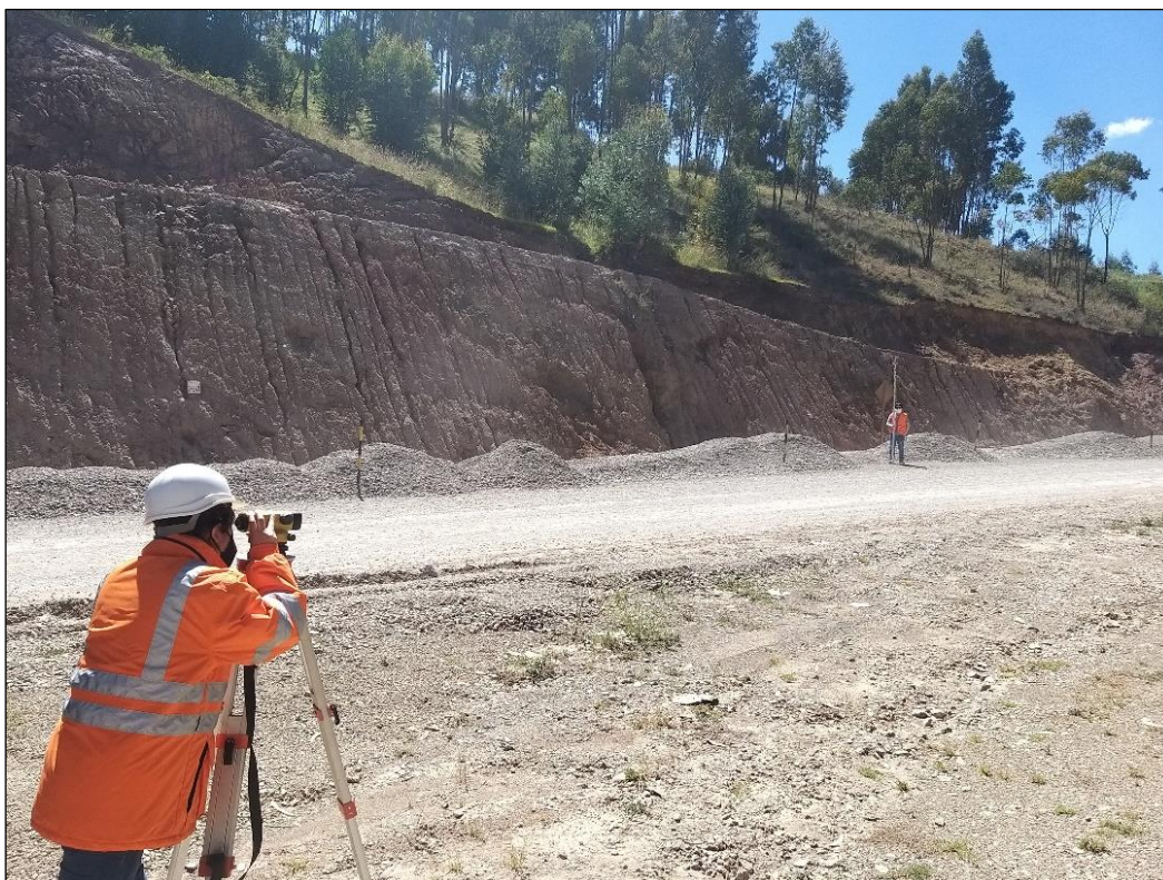
Figura 18: a). Toma de puntos con el Nivel Topográfico, para la determinación de cotas de origen (22 de Mayo del 2021).
