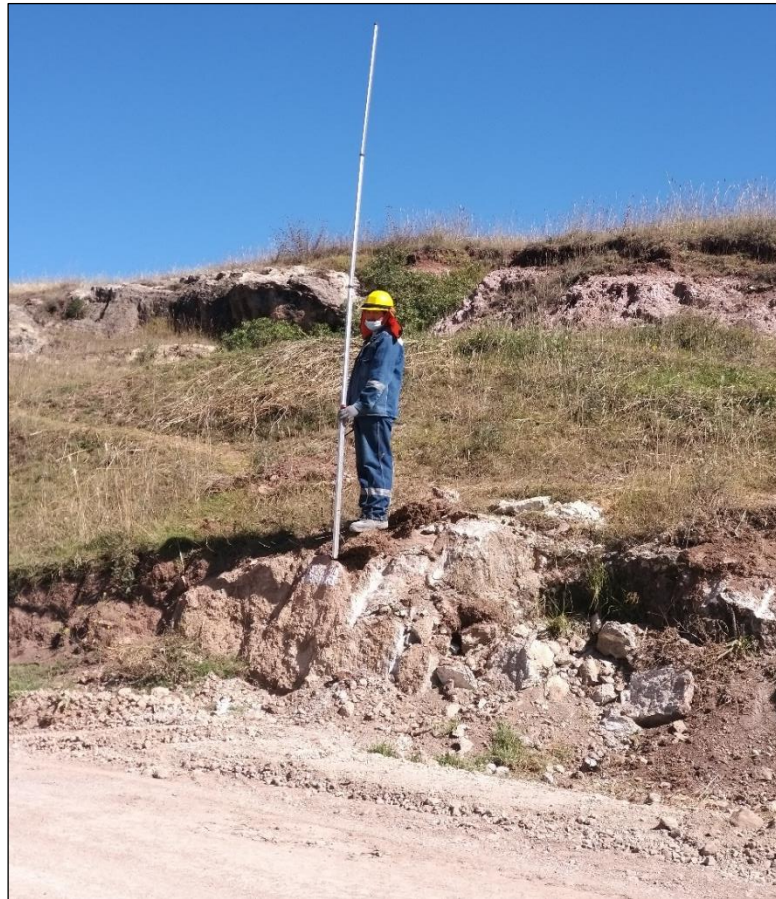
Figura 31: c). Toma de puntos de desnivel. Se contó con el apoyo por parte del personal obrero de la presente obra: “Mejoramiento de la Carretera Izcuchaca Cruzpata, Provincias de Anta y Urubamba-cusco” (05 de Junio del 2021).
