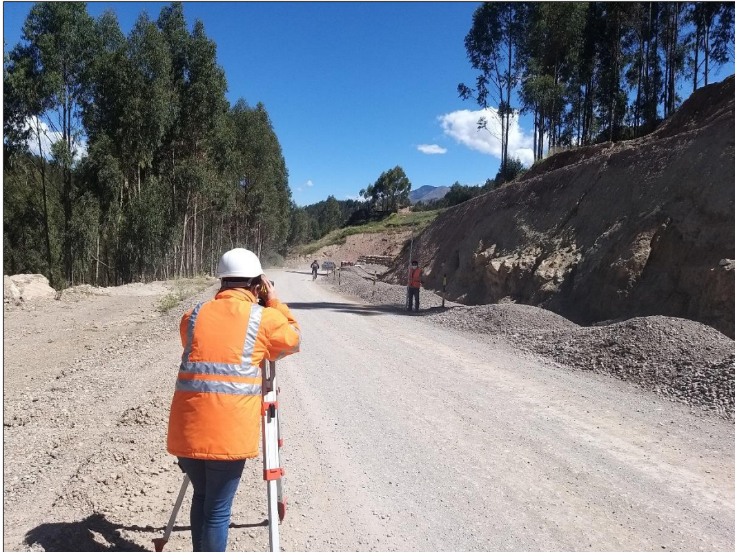
Figura 19: b). Toma de puntos con el Nivel Topográfico, determinación de desniveles (22 de Mayo del 2021).
