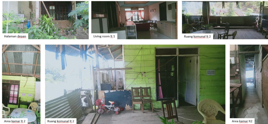
Gambar 5. kondisi ruang eksisting (Sumber : Dokumen pribadi)
