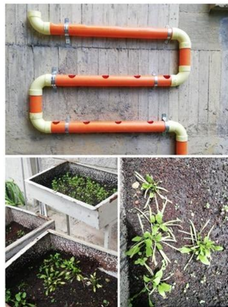
Figura 4. Construcción del cultivo hidropónico. Fuente: elaboración propia
