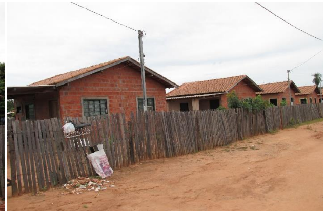
Figura 10: Conjunto habitacional Vila Igreja de Pedra I
