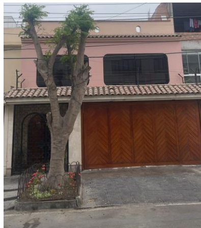
Figura N. °24: Foto de fachada
