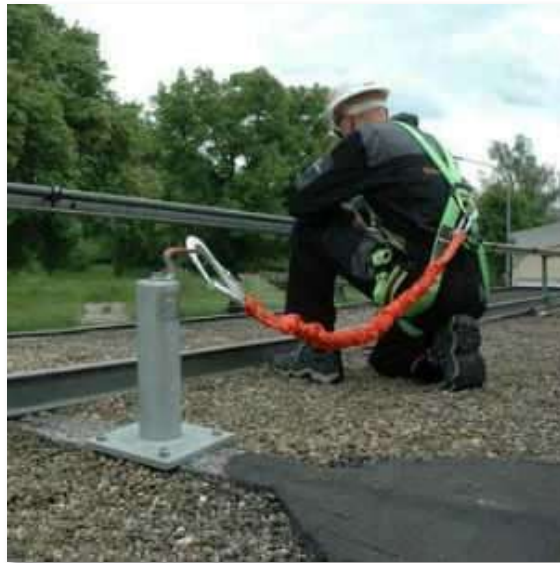
Figura 22: Punto de anclaje restrictivo Fuente: Pro alt ingeniería
