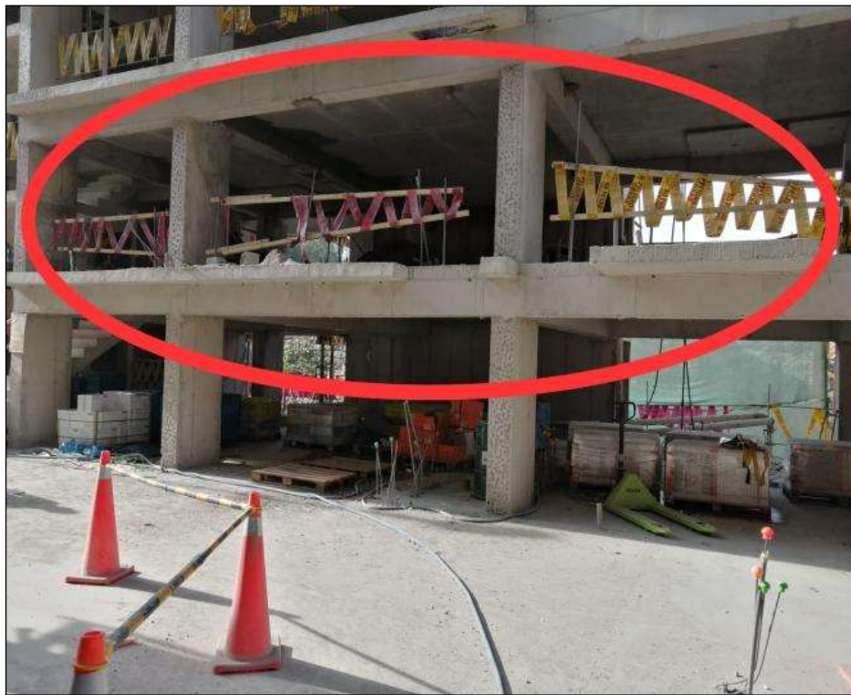
Figura 19: Área destinada a trabajos en altura superior a 2.50 m Fuente: Elaboración propia
