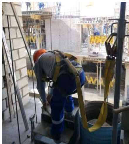
Figura 23: Operario albañil anclado en poste Fuente: Elaboración propia
