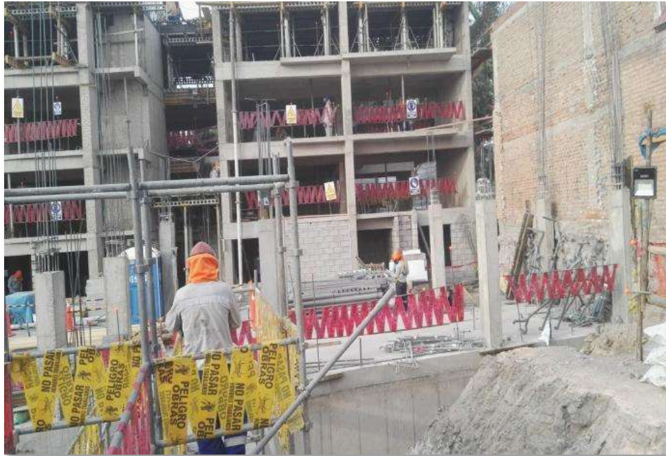
Figura 16: Área de trabajo donde se instalan puntos de anclaje Fuente: Elaboración propia
