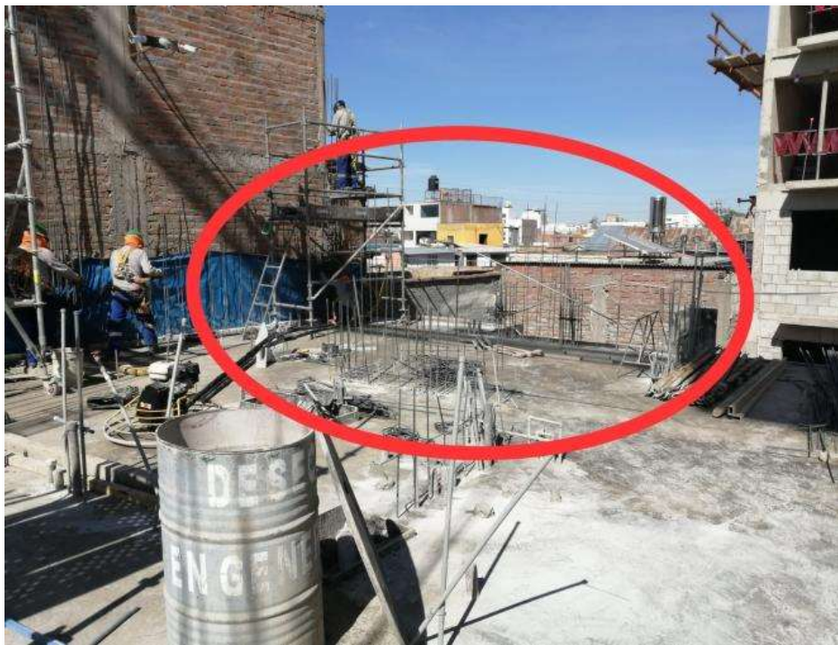
Figura 15: Trabajos en altura, uso de andamios normados Fuente: Elaboración propia
