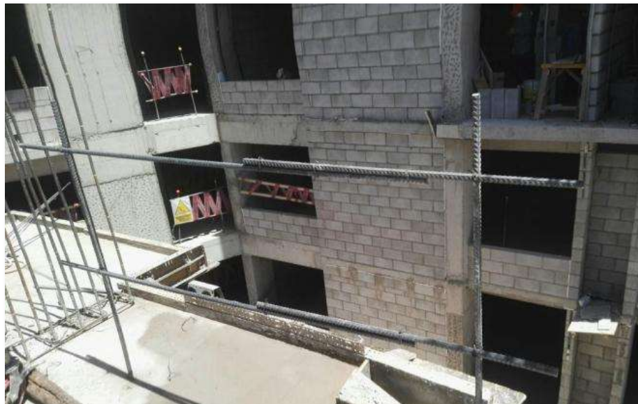
Figura 13: Torre B- Instalación de barandas de protección Fuente: Elaboración propia
