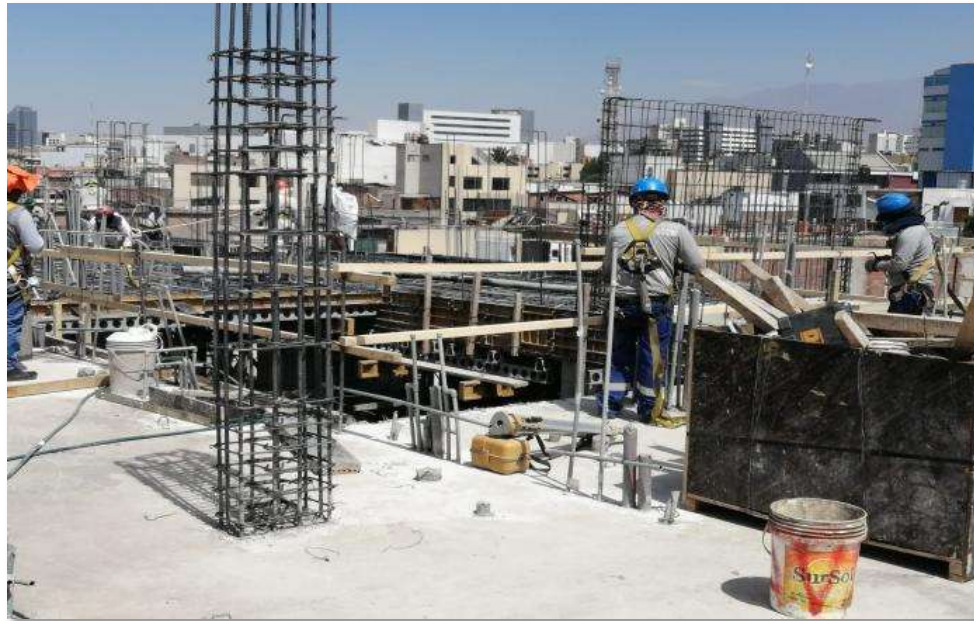
Figura 20: Piso 4 instalación de paneles y fenólico Fuente: Elaboración propia
