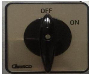
**Figura 64-3:** Seccionador trifásico 32A Camsco
