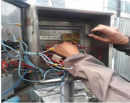
**Figura 11-3:** Desmontaje del sistema eléctrico
