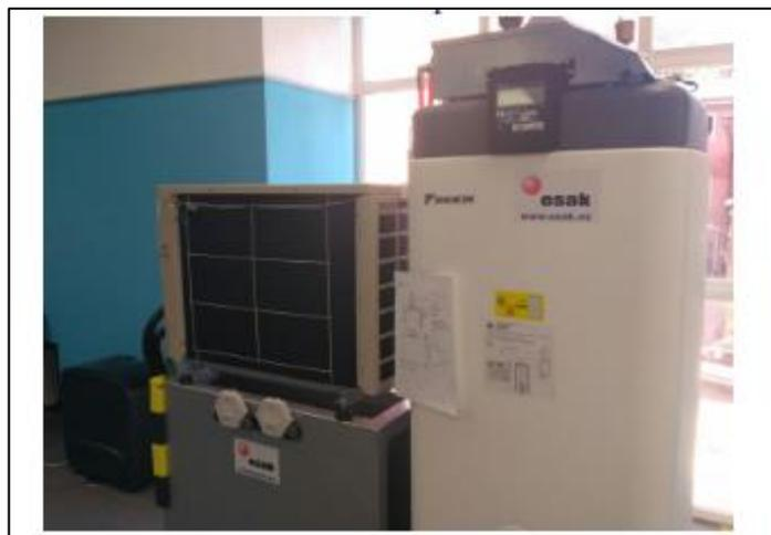
**Figura 26-1:** Bomba de calor junto al depósito de ACS
