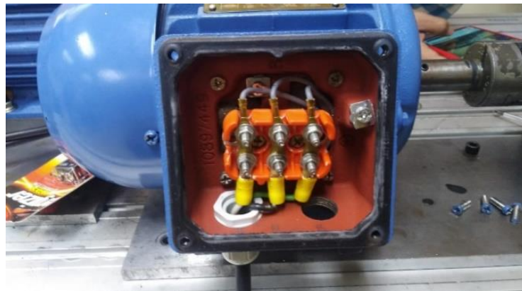
Figura 5-3: Cambio de terminales y cables de conexión
