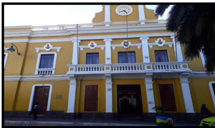
Figura 1-3: Instalaciones del GADM-Guaranda
