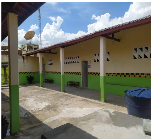
Figura 1 – Estrutura Física da Escola.
