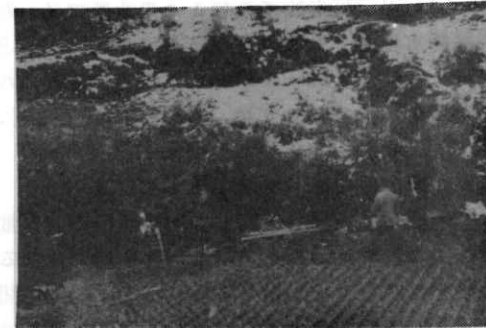
写真-4 地下水排除孔からの流量測定
