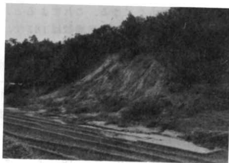
写真—2 農地に接する崩壊
