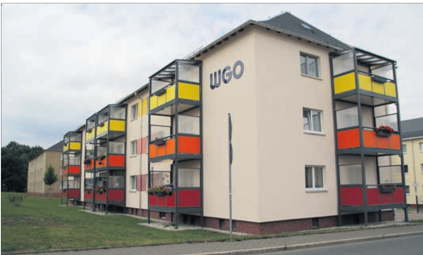
WGO Wohngebäude in der Bergarbeitersiedlung.
