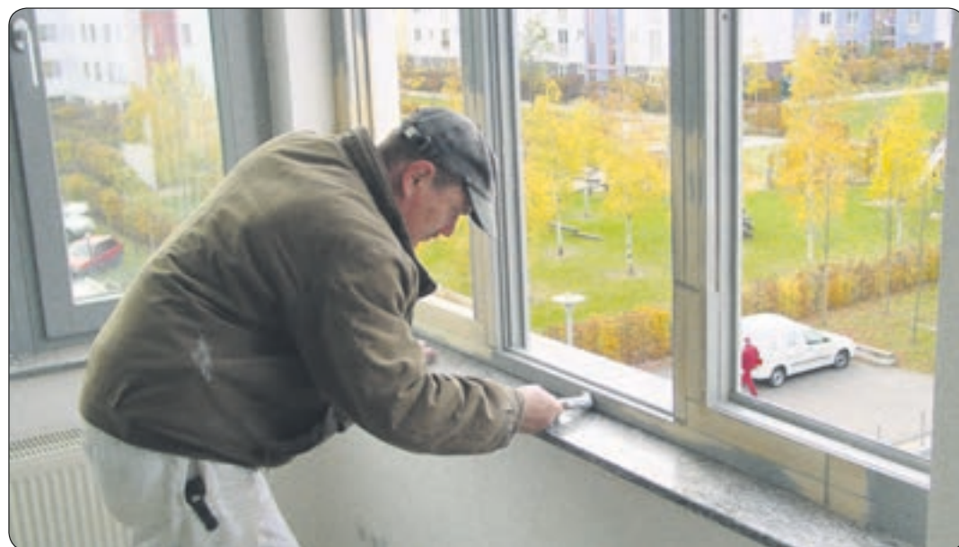
Ein repariertes Holzfenster kann nach dem Anstrich wieder wie neu aussehen. Foto: djd/Repair Care International B.V.
