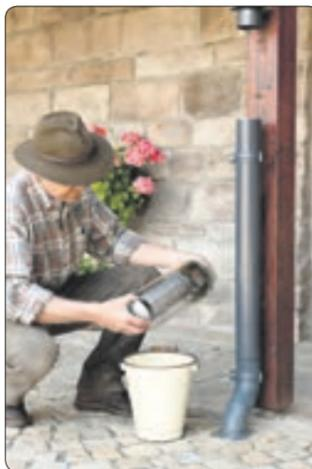
Erfinder Jürgen Huß bei der Reinigung des Fallrohrfilters.
