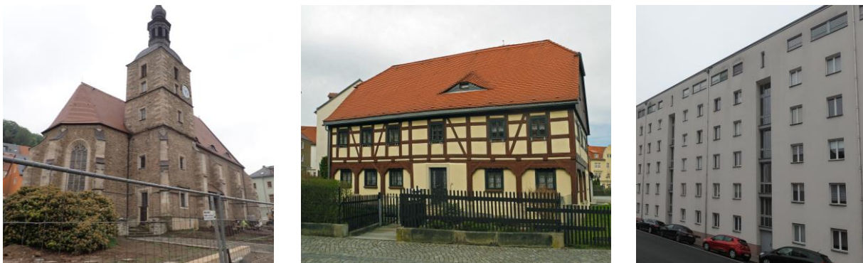
Abbildung 7: Denkmalgeschützte Gebäude verschiedener Formen und Größen: Wolfgangskirche in Glashütte (1535), Umgebindehaus in Neustadt in Sachsen (1. Hälfte 19. Jh.), Wohn- und Bürogebäude in Dresden-Striesen (1920) (Bild Mitte: SchiDD, lizenziert unter CC-BY-SA 4.0)
