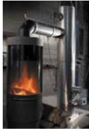
Abbildung 2: Kaminintegrierter Carola-Abscheider.
