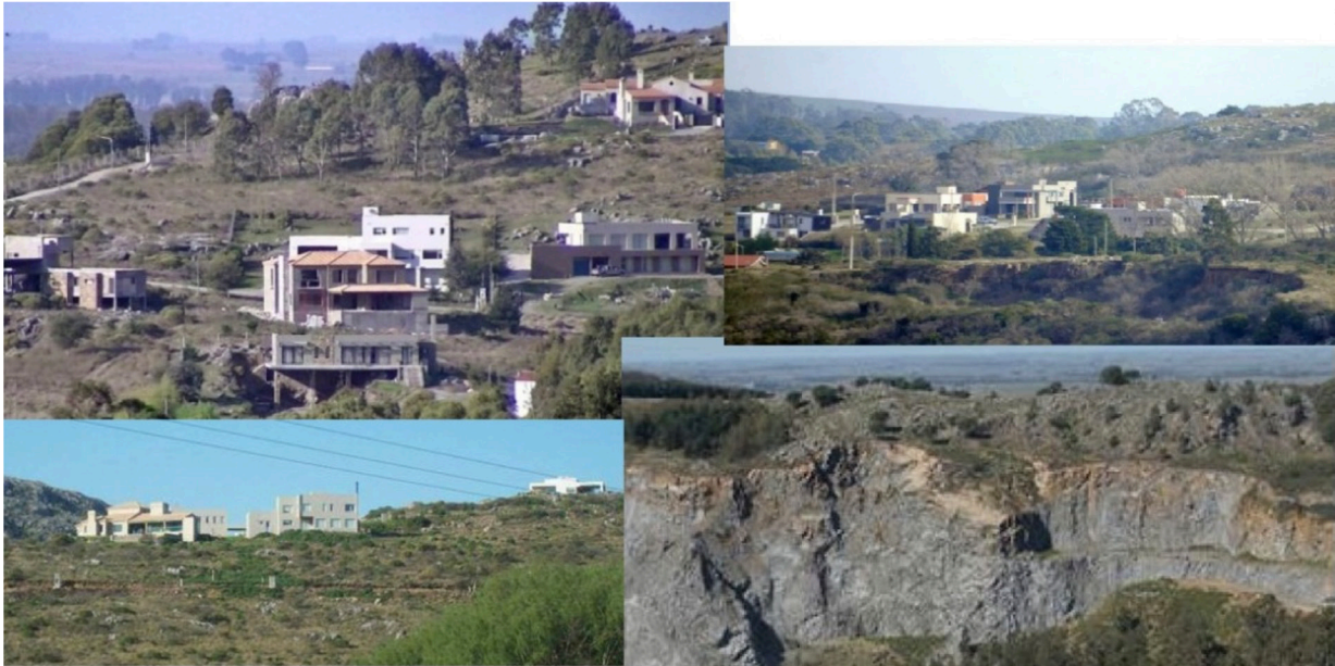
Figura 3 Construcciones y minería abandonada
