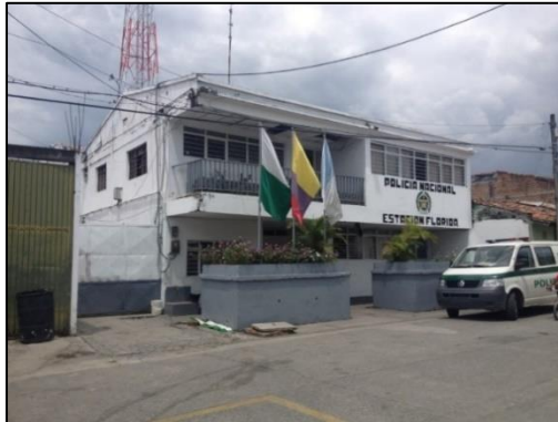
Figura 3-9 - Estado actual de la instalación policial.
