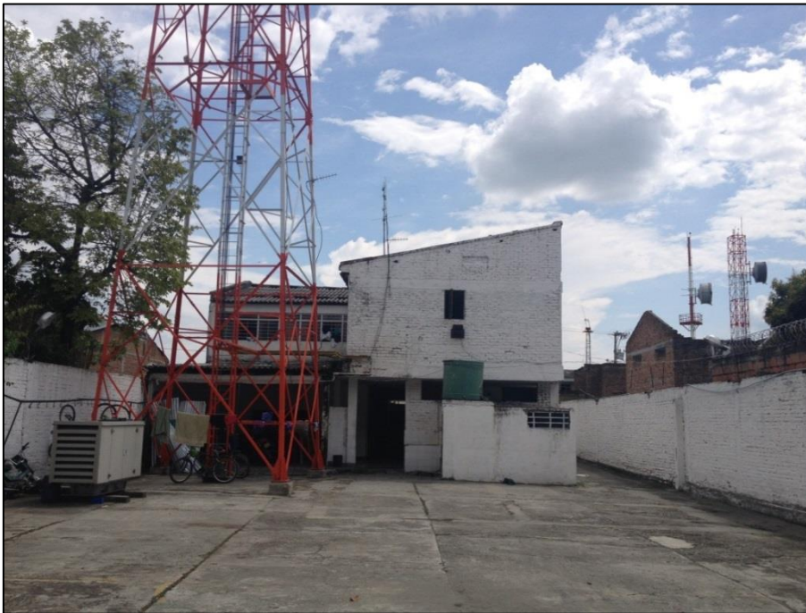
Figura 9: Vista interna del predio costado sur construcción existente
