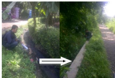
Gambar 25. Pembangunan Plengsengan.
