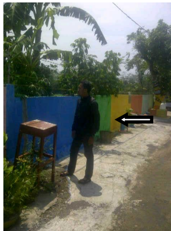
Gambar 26. Pembangunan Pagar Pembatas Perum GWI. (Sumber : Dokumentasi Pribadi, 2014)
