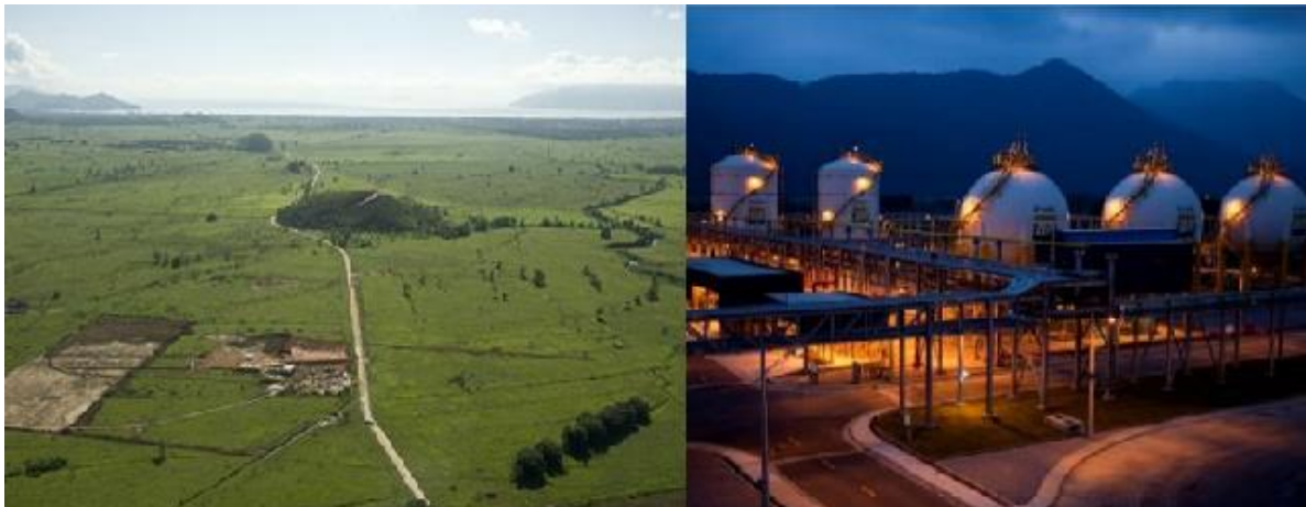
Figura 29: Vista aérea do local de implantação da UTGCA em 2007 e pronta para a partida operacional em 2011. Fonte: (PETROBRAS, 2012)
