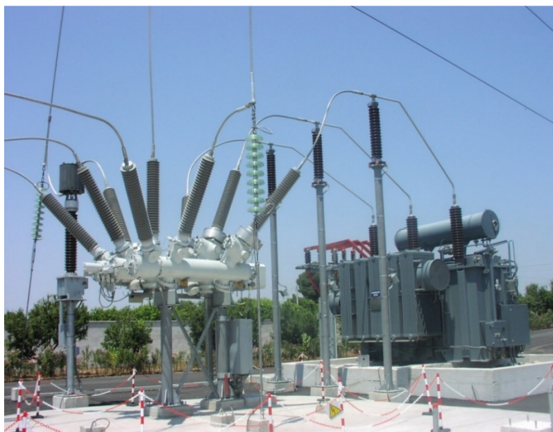
Figura 4.10 – Bay típico da solução compacta MTS
