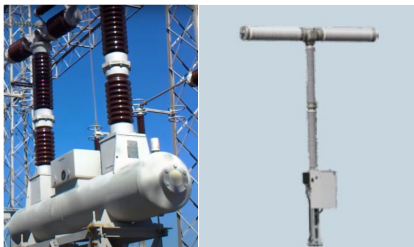
Figura 1.2 – Disjuntor a ar comprimido e a SF 6 respectivamente
