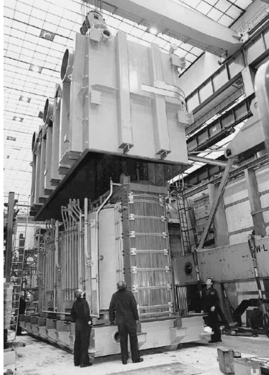
Figura 2-28 – Montagem do tanque de um transformador.
