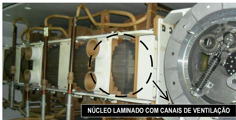
Figura 2-17 - Núcleo durante construção.
