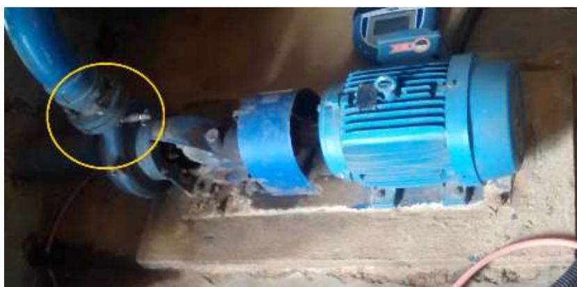
Figura 47 - Local de instalação dos transdutores
