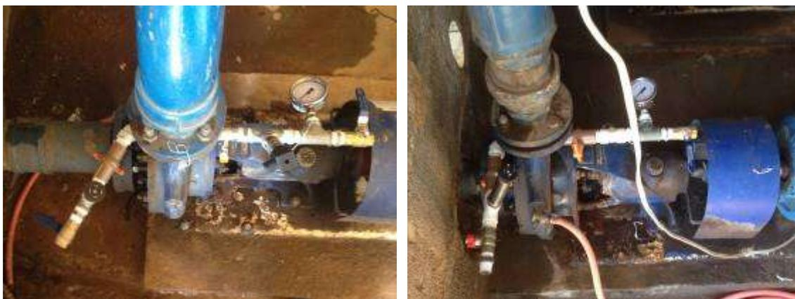
Figura 48 - Transdutores de pressão instalados
