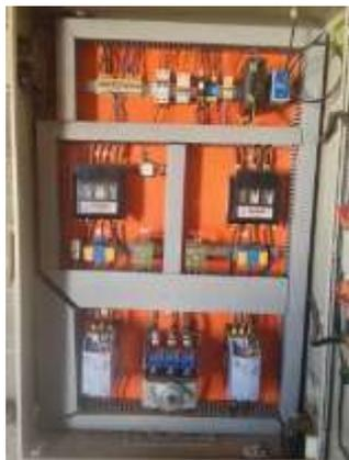
Figura 45 - Painel de comando dos motores
