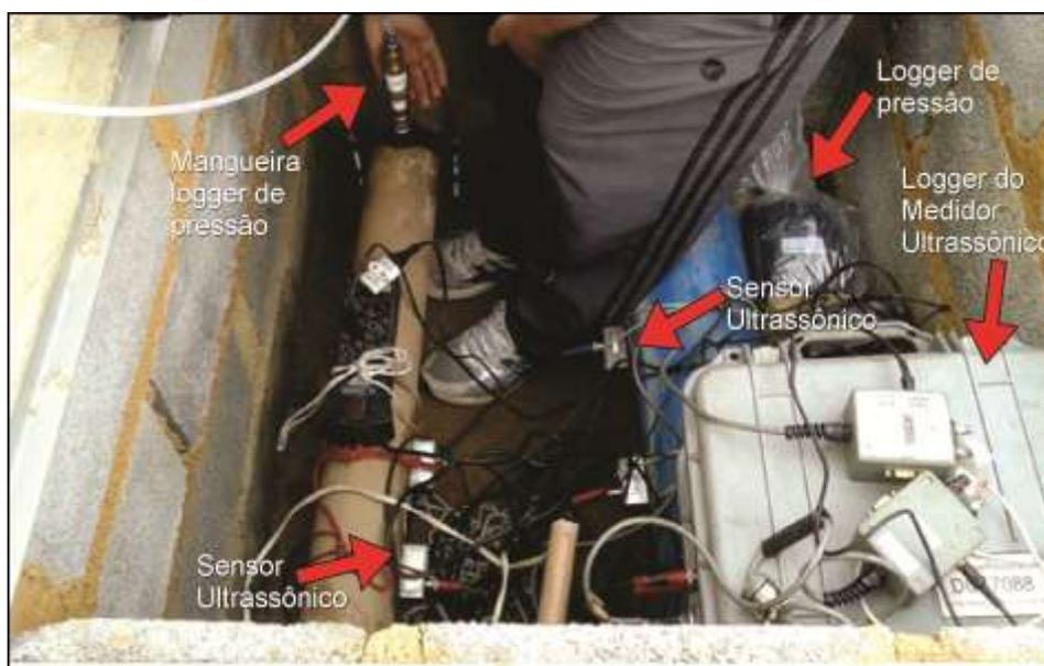
Figura 29 - Medidores de vazão (ultrassônicos) e de pressão instalados em R3
