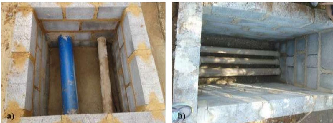
Figura 23 - Caixa para alocação dos medidores em R3 (a) e em R4 (b)
