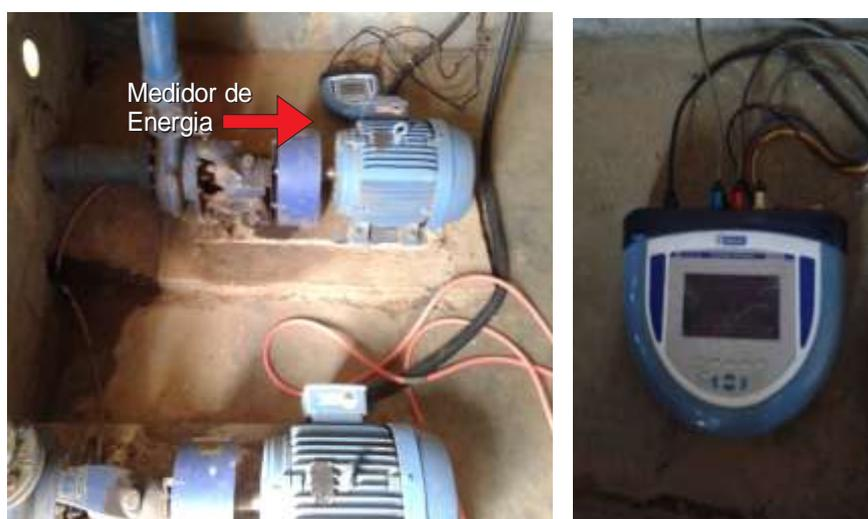
Figura 30 - Medidor de parâmetros de energia instalado na casa de bombas no R3
