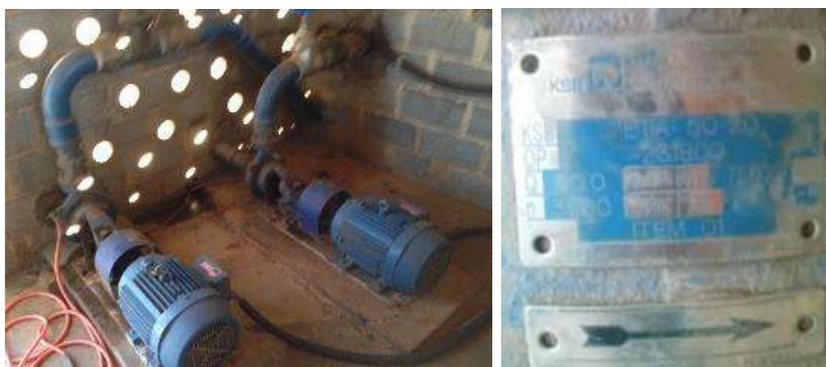
Figura 44 - Bombas do sistema de abastecimento e placa de modelo das bombas
