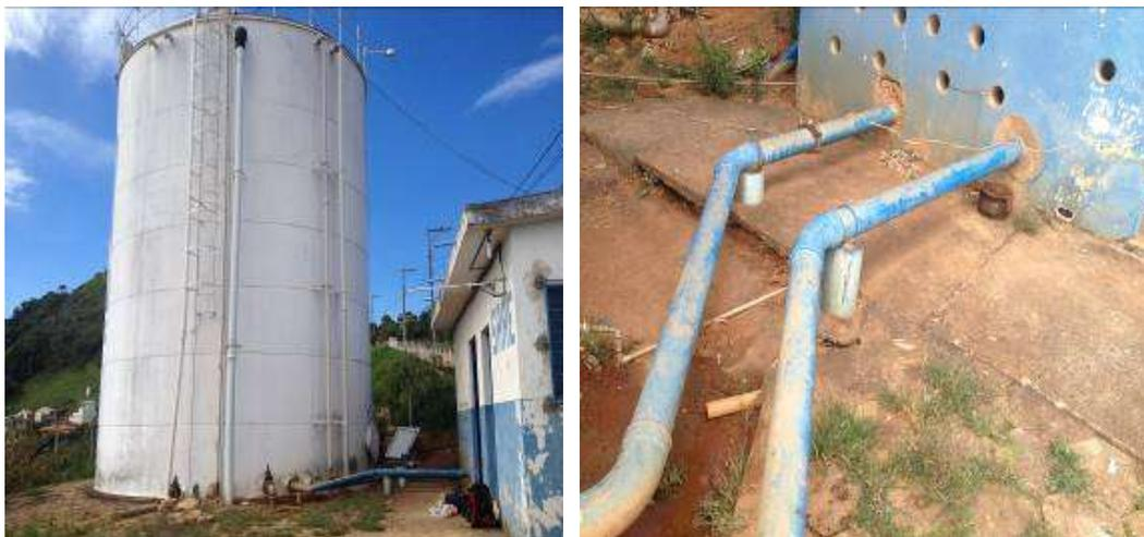
Figura 13 - Reservatório R3 e sucção das bombas
