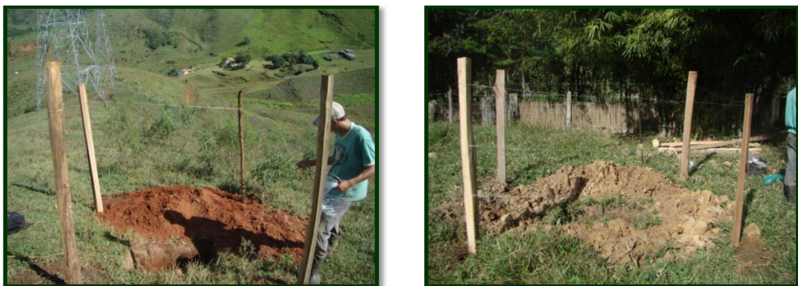
Figura 4.12. Cercamento das trincheiras nas catenas da sub-bacia José Pereira.
