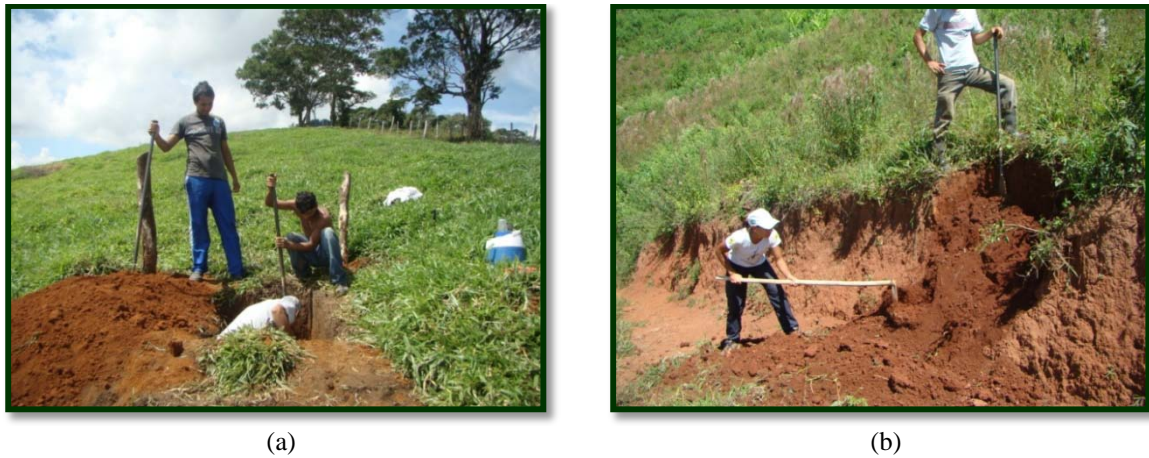
Figura 4.11. Abertura de trincheira (a) e limpeza de cortes de estrada (b) na sub-bacia do ribeirão José Pereira.
