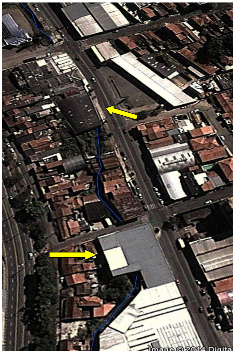
Figura 46: Posto de Gasolina e Estabelecimentos Comerciais construídos “sobre” o canal do Ribeirão Lavapés Bragança Paulista SP. Fonte Google Earth. 2014.
