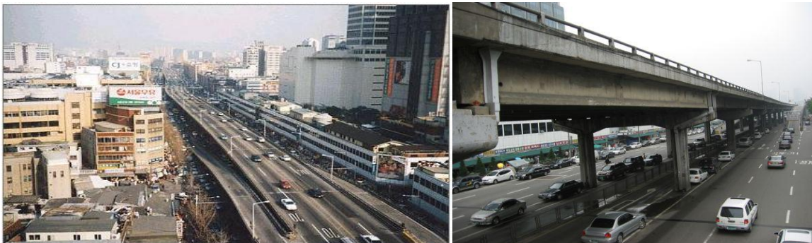
Figura 4: Antes do Processo de Revitalização do Rio Cheonggyecheon, em Seul, na Coreia do Sul, em 2002. Fonte: GGN, 2014.
