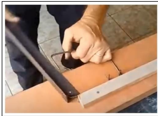
Figura 14 - Produção de estribos.
