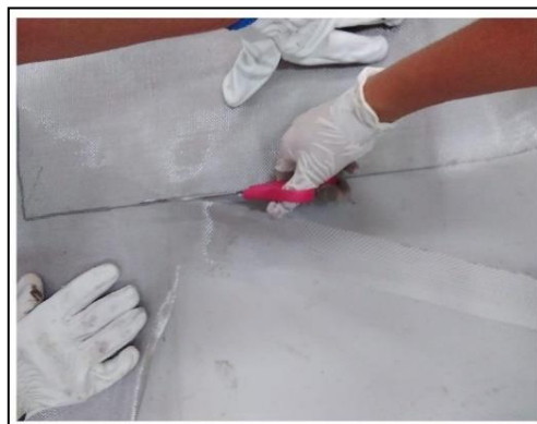
Figura 28 - Corte das telas em aço.
