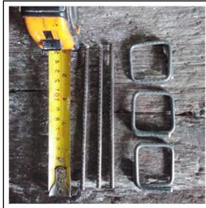
Figura 25 - Estribos dobrados.
