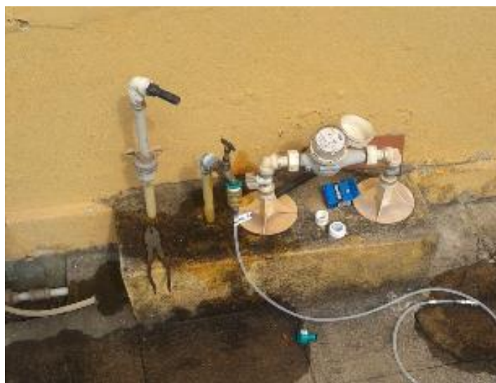
Figura 30 - Ponto de monitoramento do nó 14 onde foi necessária a troca de torneira para efetuar as medições.
