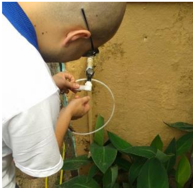
Figura 31 – Vedação da mangueira do logger de pressão a fim de evitar vazamentos e erro de medição.
