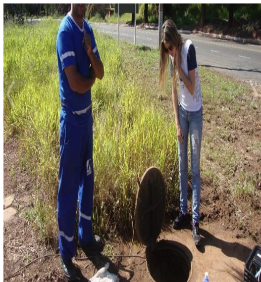
Figura 38 - Funcionário do SAAE – São Lourenço acompanhando instalação de equipamento medidor de vazão no Poço de visitas – entrada do setor de estudo.
