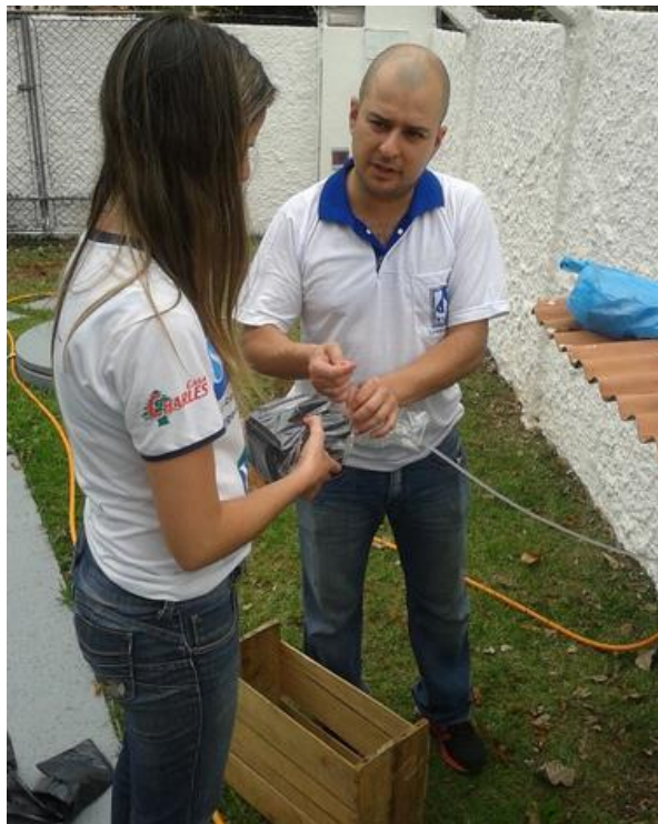
Figura 28 - Instalação dos loggers de pressão nas residências e proteção do aparelho.
