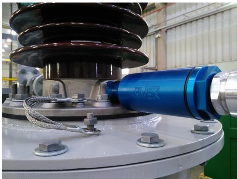
Figura 40 - Foto detalhando o acoplamento capacitivo, fonte: foto do próprio autor
