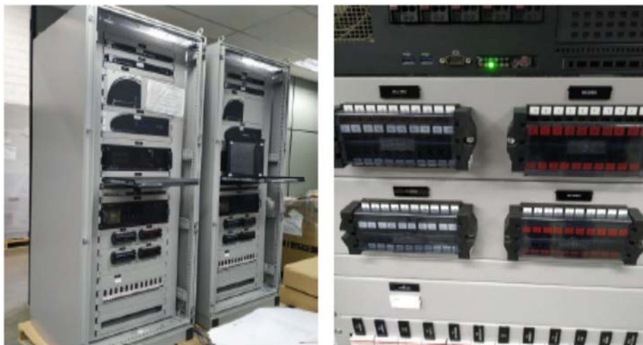
Figura 33– Montagem dos painéis em fabrica
