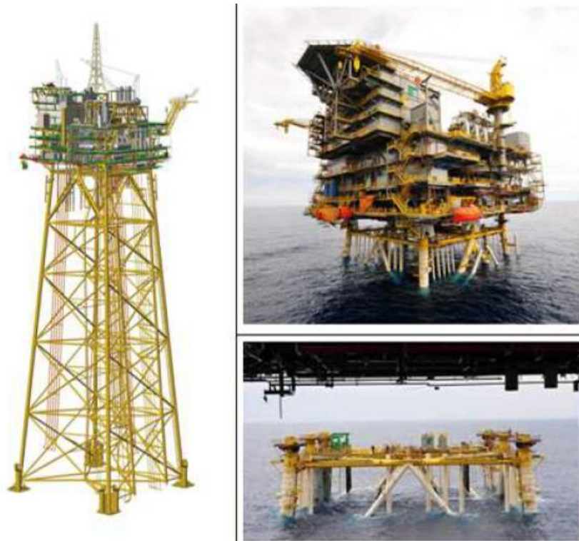
Figura 2.3 Projeto e fotografia da Plataforma de Mexilhão. Adaptado de (PETROBRAS)
