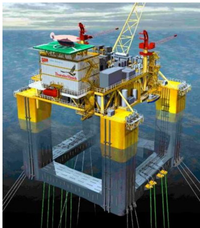
Figura 2.4 Imagem de projeto de plataformas semi-submersível. Adaptado de (FALTINSEN, 1998).
