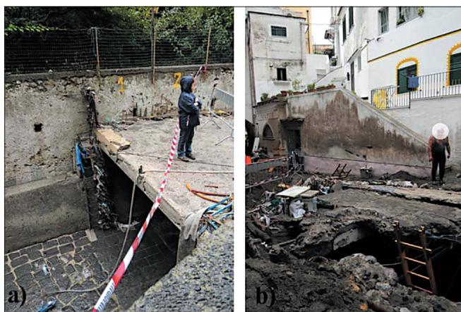
Figura 3 - a) ingresso canale tombato, b) punto di rottura del canale tombato (p2).
