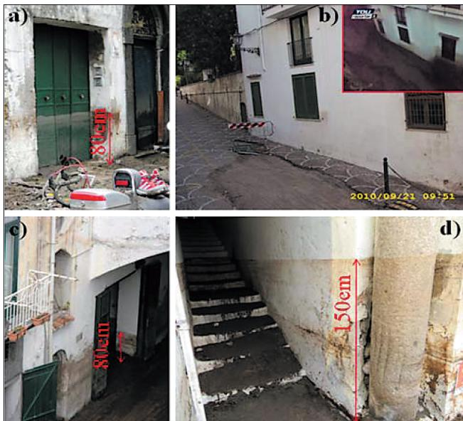
Figura 5 - Tracce lasciate dalla corrente: a) misura del tirante max in corrente lenta di  $p1$ , b) rimozione della pavimentazione nel tratto ad elevata pendenza tra i punti  $p1$  e  $p2$ , c) misura del tirante max in corrente veloce di  $p3$  d) misura del tirante max in corrente lenta in  $p3$ .
