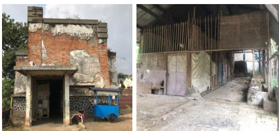
Gambar 1 Kondisi Bangunan RPH dan Bangunan Kandang
