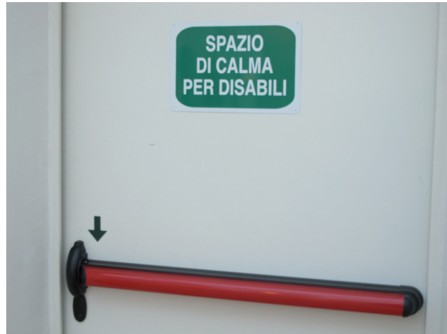
Fig. 5. Segnale identificativo di uno spazio calmo posto sulla porta di accesso. La scritta "Spazio di calma per disabili" rileva quanto lavoro ci sia ancora da fare, anche in termini di conoscenza diffusa.
