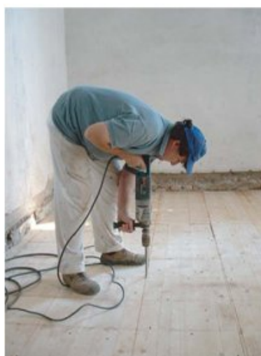
Figura 2.34 - Fase di realizzazione di un doppio tavolato incrociato (Zerbinati, Gulli, 2006).
