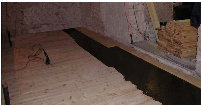
Figura 2.32 - Esempio di doppio assito incrociato (Zerbinati, Gulli, 2006).
