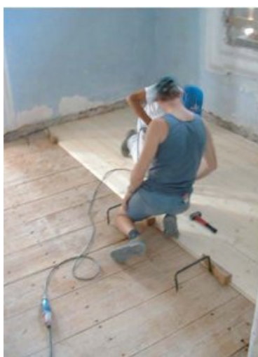
Figura 2.33 - Fase di realizzazione di un doppio tavolato incrociato (Zerbinati, Gulli, 2006).
