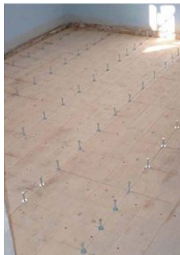
Figura 2.34 - Fase di realizzazione di un doppio tavolato incrociato (Zerbinati, Gulli, 2006).
