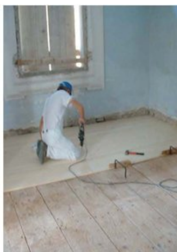
Figura 2.33 - Fase di realizzazione di un doppio tavolato incrociato (Zerbinati, Gulli, 2006).
