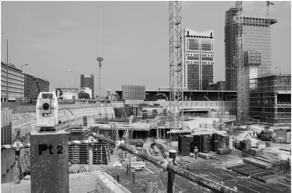
Figura 3 – Vertice topografico della rete topografica del cantiere Porta Nuova Garibaldi.
