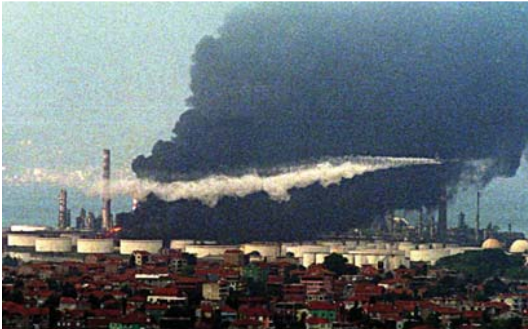
Foto 1 - Tüpra: Incendio della raffineria a seguito del terremoto del 1999.
