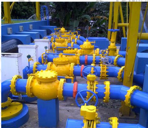
Gambar 5.11 Pompa ke pelanggan dari Rumah Pompa Mojolangu.
