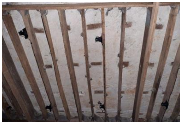
Gambar 5. Sirip kayu dalam rumah burung walet.
