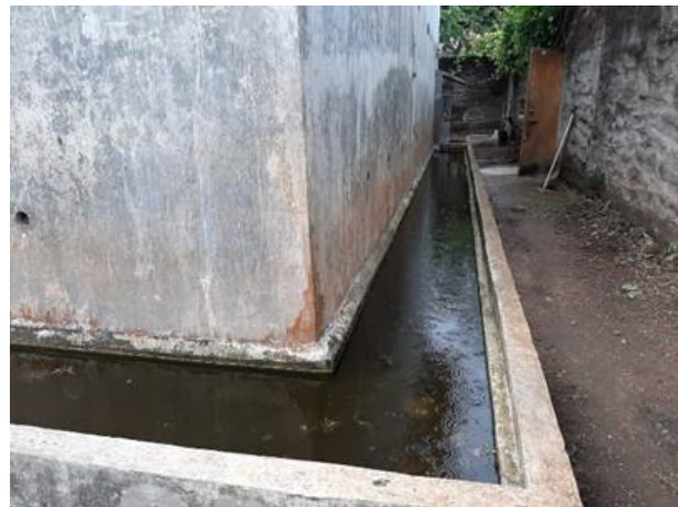
Gambar 6. Rumah walet di Pulau Jawa dengan kolam di bagian luar RBW.
