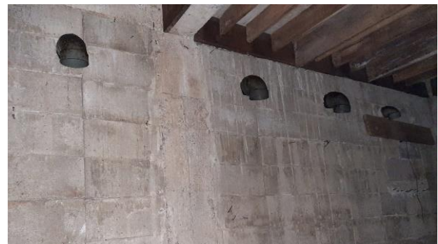
Gambar 4. Pipa paralon sebagai lubang ventilasi
